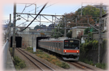
武蔵野線トンネル入口（西恋ヶ窪）
